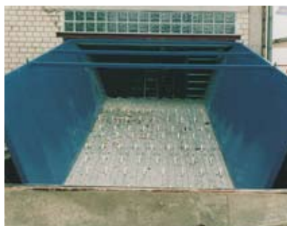
Lünen/ Alemania Garaje para reciclaje de basuras Lünen, Allemagne Garage de recyclage des déchets
