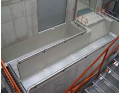
Viena, Austria Reciclaje de basuras doméstica Vienne, Autriche Recyclage des déchets ménagers
